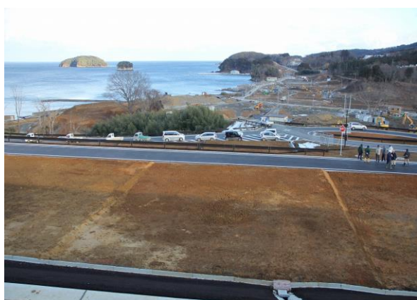
(完成した戸倉地区松崎団地からの眺望)
