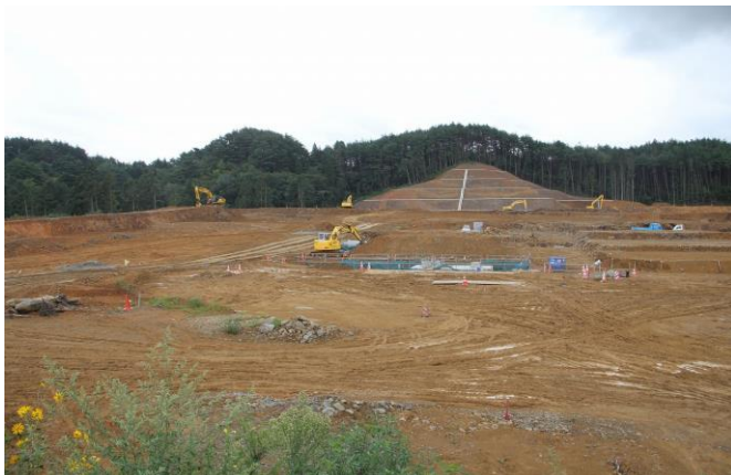
(戸倉防集団地の造成工事現場の様子)
