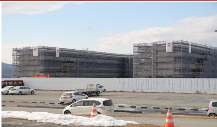
(建設が進む志津川・東地区災害公営住宅③街区)
