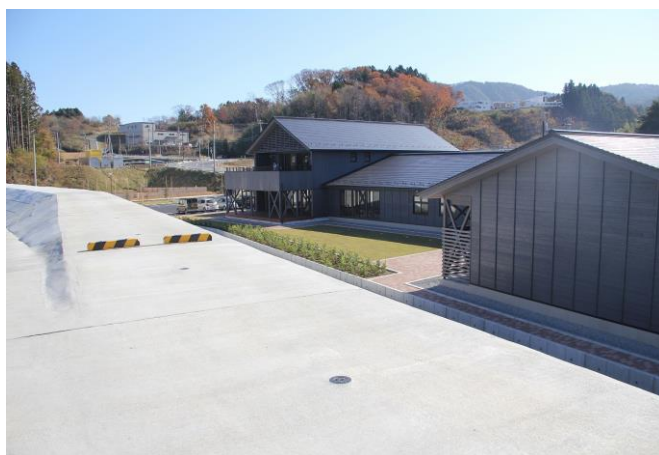
（ビジターセンター全景。右手奥は「県自然の家」）
