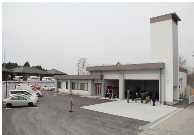
（完成した南三陸消防署歌津出張所＝4月17日撮影）
