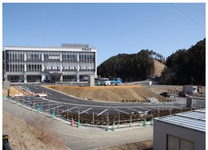
(完成した南三陸警察署の新庁舎)
