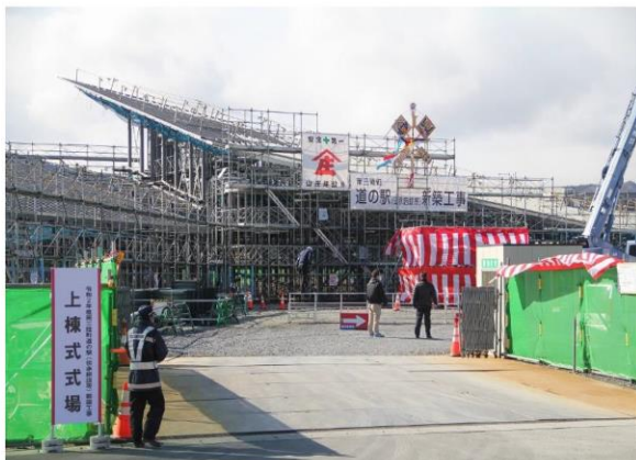
(10月の開業に向け工事が進む道の駅＝上棟式当日撮影)
