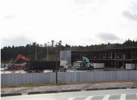
(役場仮庁舎の解体作業の様子=11月25日撮影)
