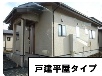
災害公営住宅
