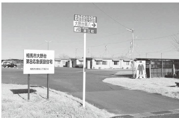
▲今年3月末、その役目を終えることになった大野台第8応急仮設住宅
