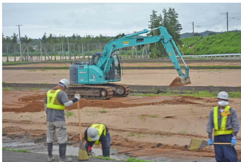
酒田地区の除染作業風景
